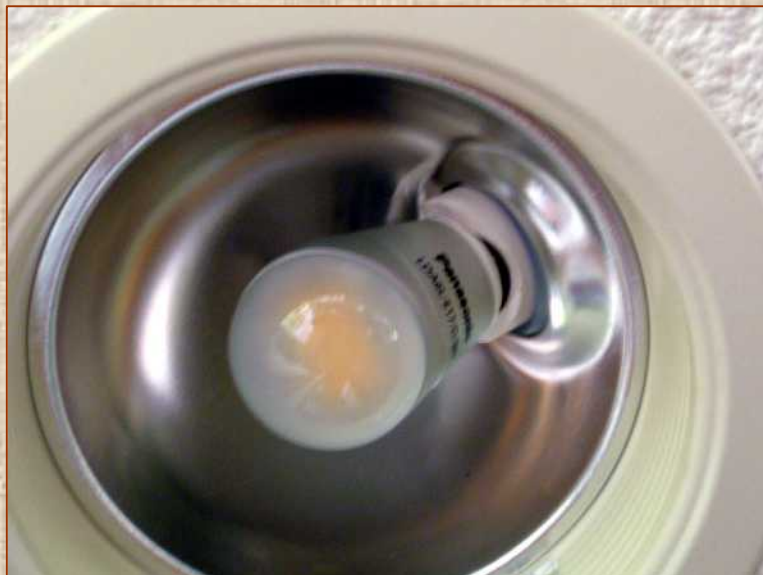
早速 LED 球に交換してみたが、なぜか点灯しない?? 器材は、コイズミ ADE550100 (2002 年 7 月製)
